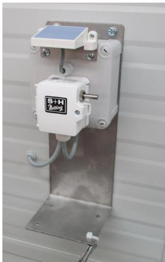
Sobald sich Feuchtigkeit auf der Kontaktoberfläche befindet, übermittelt der Schneesensor ein digitales Signal zur angeschlossenen Anlagensteuerung.
