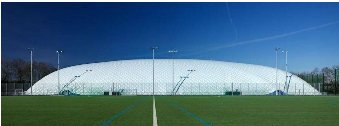
Hockeyhalle, 6.400 m 2 - "gestützt und geheizt" mit 2 x Typ K300/D (Luftleistung gesamt 48.000 m 3 /h)
